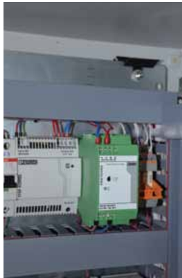
Рисунок 2 – Источники питания серии MINI и STEP для питания цепей 12 В и 24 В
