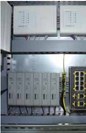
Рисунок 1 – Устройства защиты от импульсных перенапряжений для LAN Cat 5 с поддержкой технологии PoE
