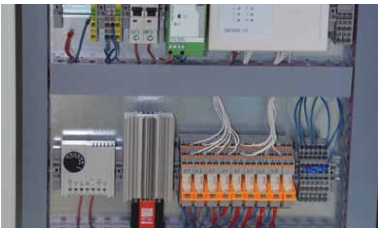
Рисунок 3 – Промежуточные реле серии Rifline с технологией подключения проводников Push-in
